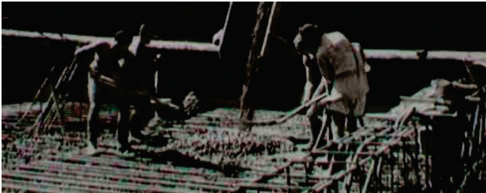
Ametró építési munkálatai [Forrás: Magyar Filmhíradó 38; 1951. szeptember. 1951: Részvétel a metróépítésben, munkaversenyben] (Az eredeti forrásból a képeket készítette: Kenéz György)
